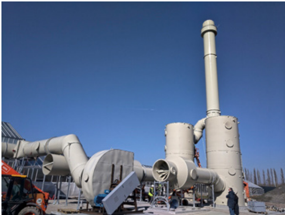
Chantier de l'unité de traitement de l'effluent gazeux
