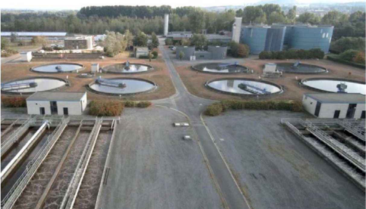
Vue aérienne de la station d'épuration de Wasmuël.
